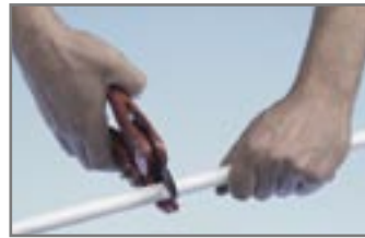
Doorknippen van de TECEflex-Alupexbuis kan met een knipschaar.
