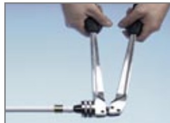
Optrompen van de buiseinde met een optromptang.
